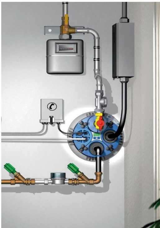
Einführung durch die Wand ( Gebäude mit Keller)
