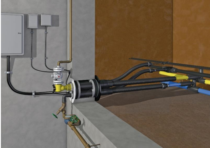
Einführung durch die Bodenplatte ( Gebäude ohne Keller)
